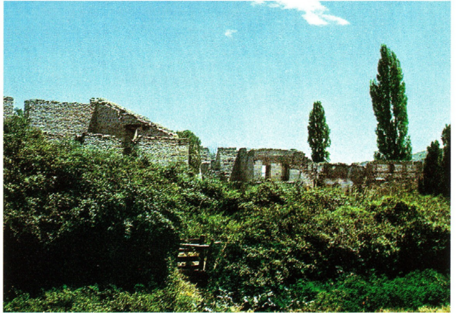
Restos de la fábrica de Manzanares el Real.
